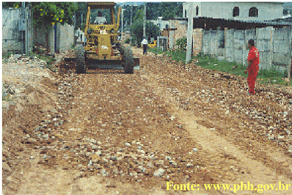
Construção de sub-base (Belo Horizonte – MG)
