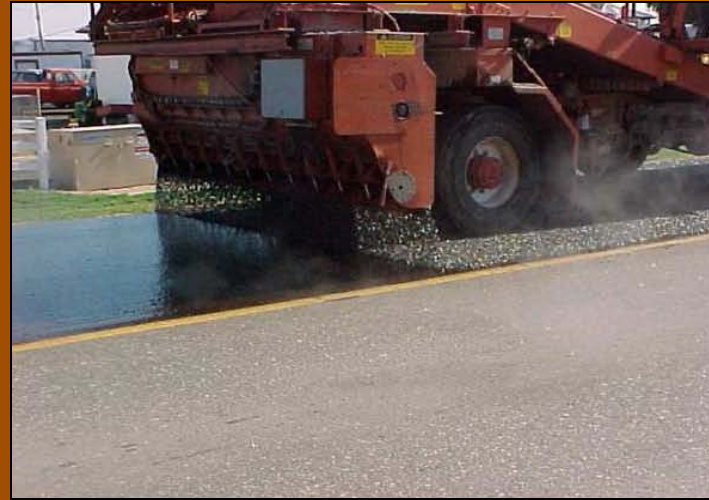
Execução do TS.
