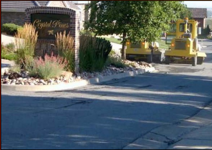
Estado inicial da via.
