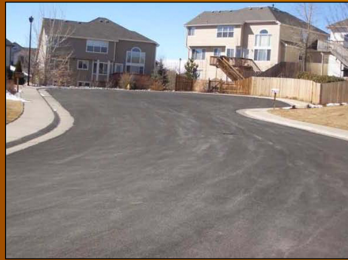
Aspecto final da via.
