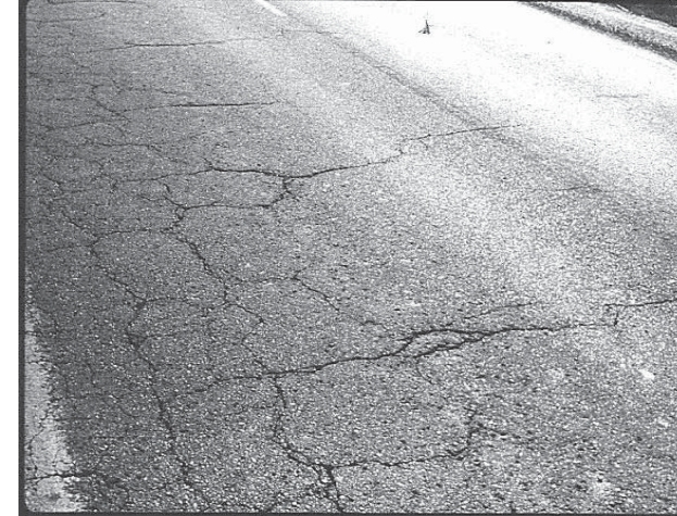
Trincamento em Blocos
